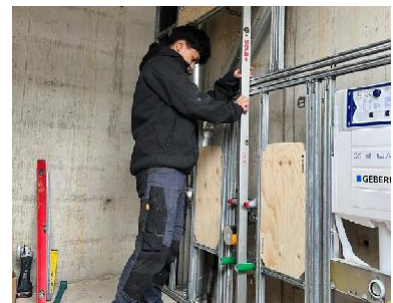
Beispiel: Sanitärarbeit, Montage Installationswand
