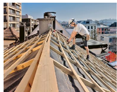
Beispiel: Zimmermannsarbeit, Montage Ziegellattung
