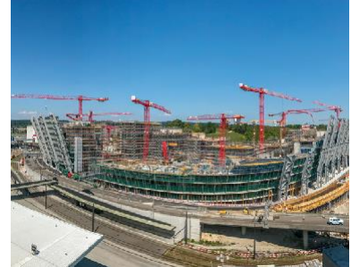
Beispiel: Grossbaustelle Zürich, „Circle“
